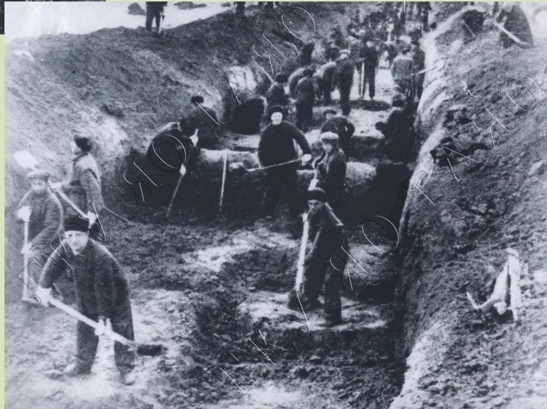
На строительстве оборонительных сооружений. 1941 г.
